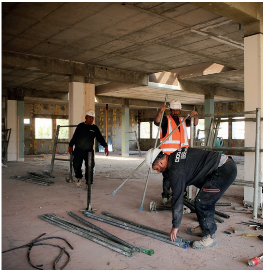
Le chantier de la nouvelle crèche.
